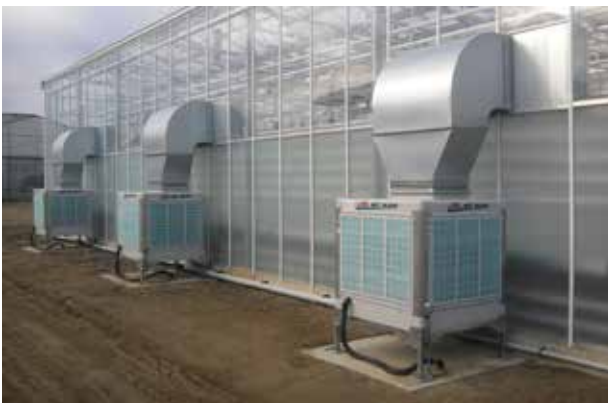
Instalación AD- 15-VS en invernadero
